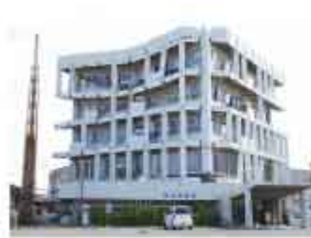
4月16日の本震により、4階部分が崩壊した宇土市本庁舎。現在は取り壊し作業が進められています。
