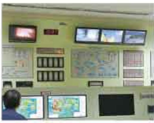
炉の中の様子はモニターで管理。燃やす温度は850~950℃。ダイオキシンが発生しにくい温度だと言われています。
