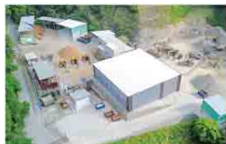
解体で発生する廃材は自社の廃棄物処理施設で適切に処理し、再資源化しています。
