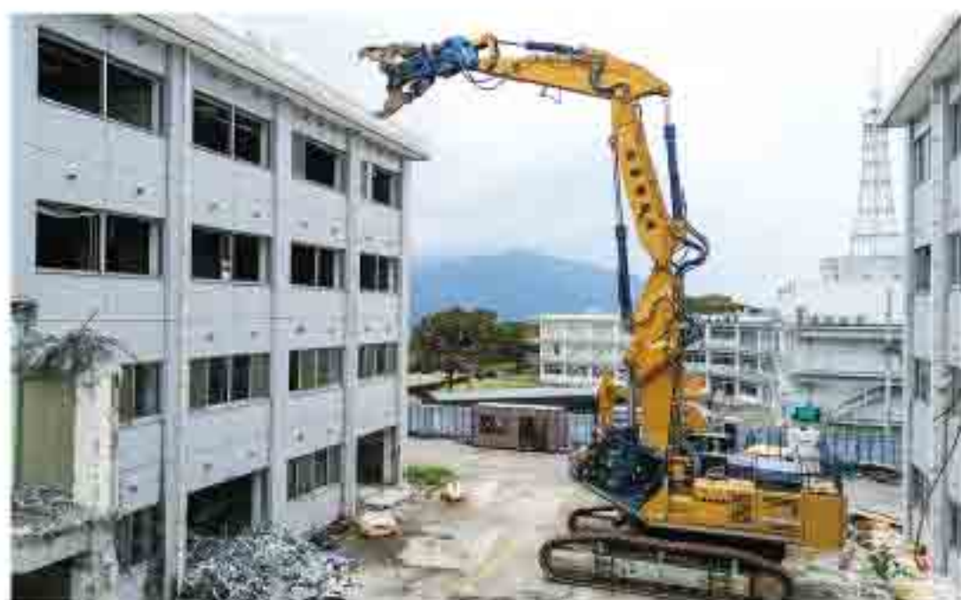
多くの重機と技術と人材で、困難な解体や機抜きなど特殊な解体工事にも迅速に対応。抜群の機動力で公共施設等の解体実績も多数。
