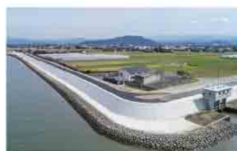
国交省をはじめ、県や多くの自治体から高く評価されています。令和5年7月 工事成績優秀企業認定/国土交通省九州地方整備局
