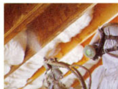
▲スプレーして固まる驚異の泡状断熱材「アイシネン工法」は、生涯にわたってズレや変質の心配がない優れた工法です。
