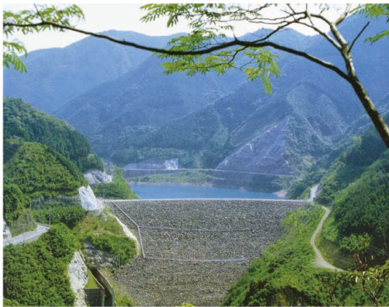
▲八代市坂本町と球磨郡五木村にまたがる大平発電所(写真は八代市坂本町油谷ダム)。昭和50年より電力の安定供給に力を発揮してきました。九州には他に、天山発電所(佐賀県)と小丸川発電所(宮崎県)の2つの揚水発電所があります。
