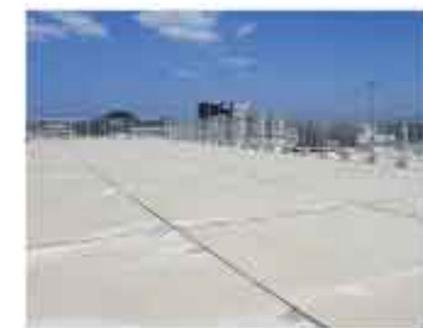
400人近くが避難できる屋上には貯水設備も
