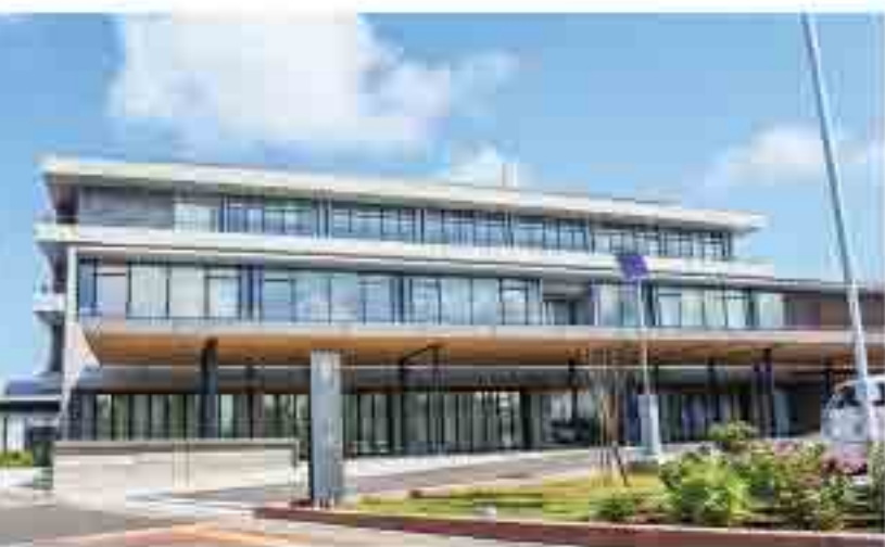
およそ2年の工事期間を経て頑丈に生まれ変わった、宇土市民待望の新庁舎。
