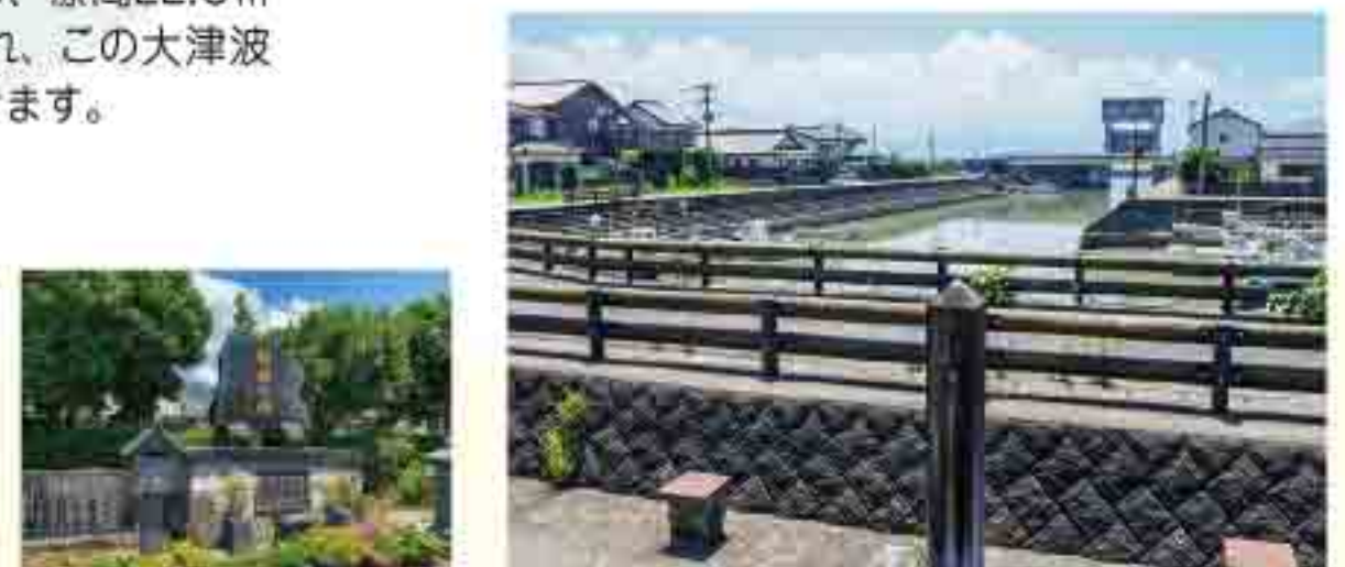
平成11年の台風18号による高潮災害の状況を示す石碑(写真左)と高潮の浸水高を示す「高潮痕跡高」。高潮の浸入口になった舟留まりと他2カ所には防潮水門が整備されました。
